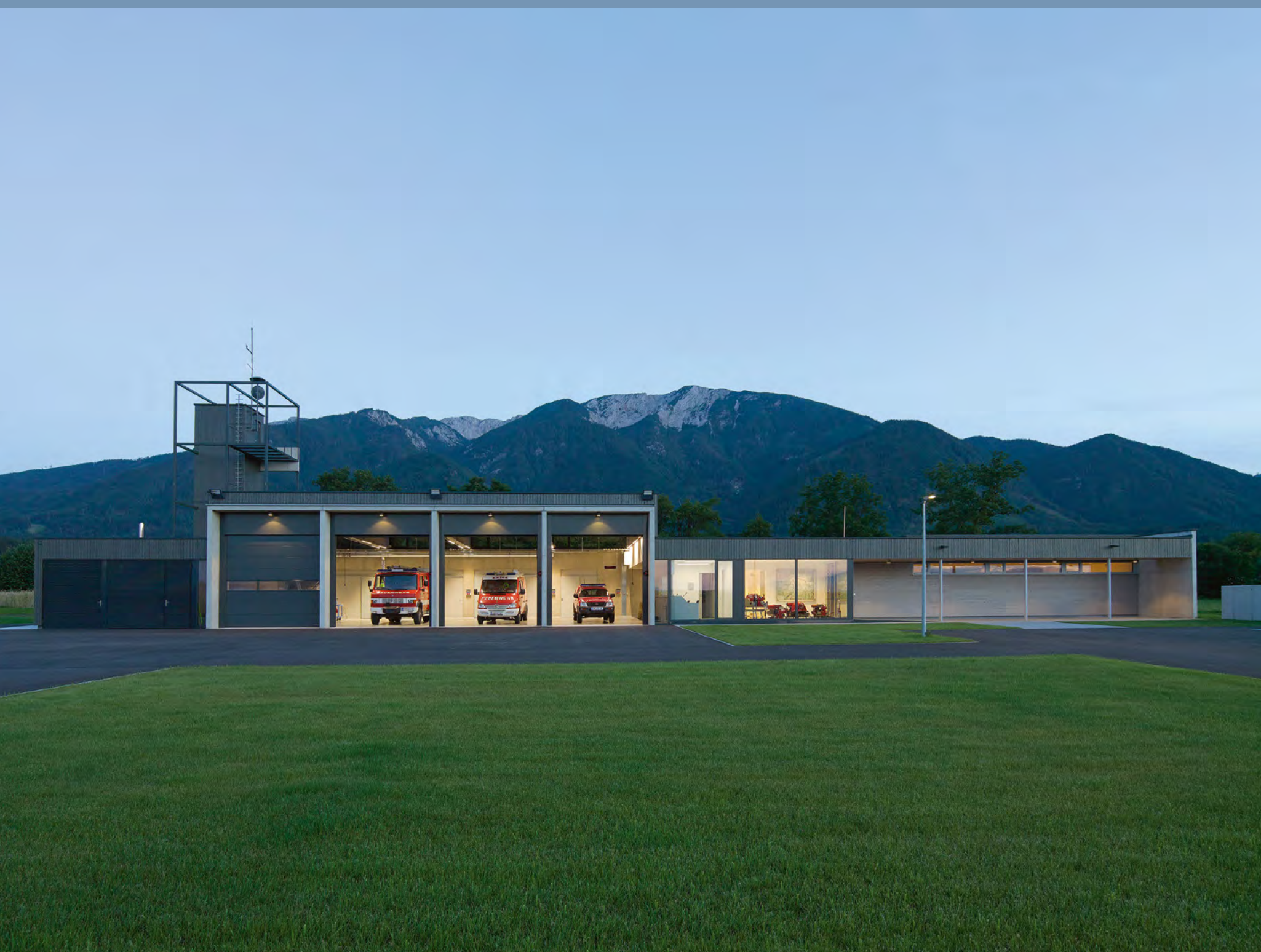
Reinhold Wetschko Feuerwehrhaus, Feistritz ob Bleiburg, Kärnten, 2020 Foto: Gisela Erlacher
