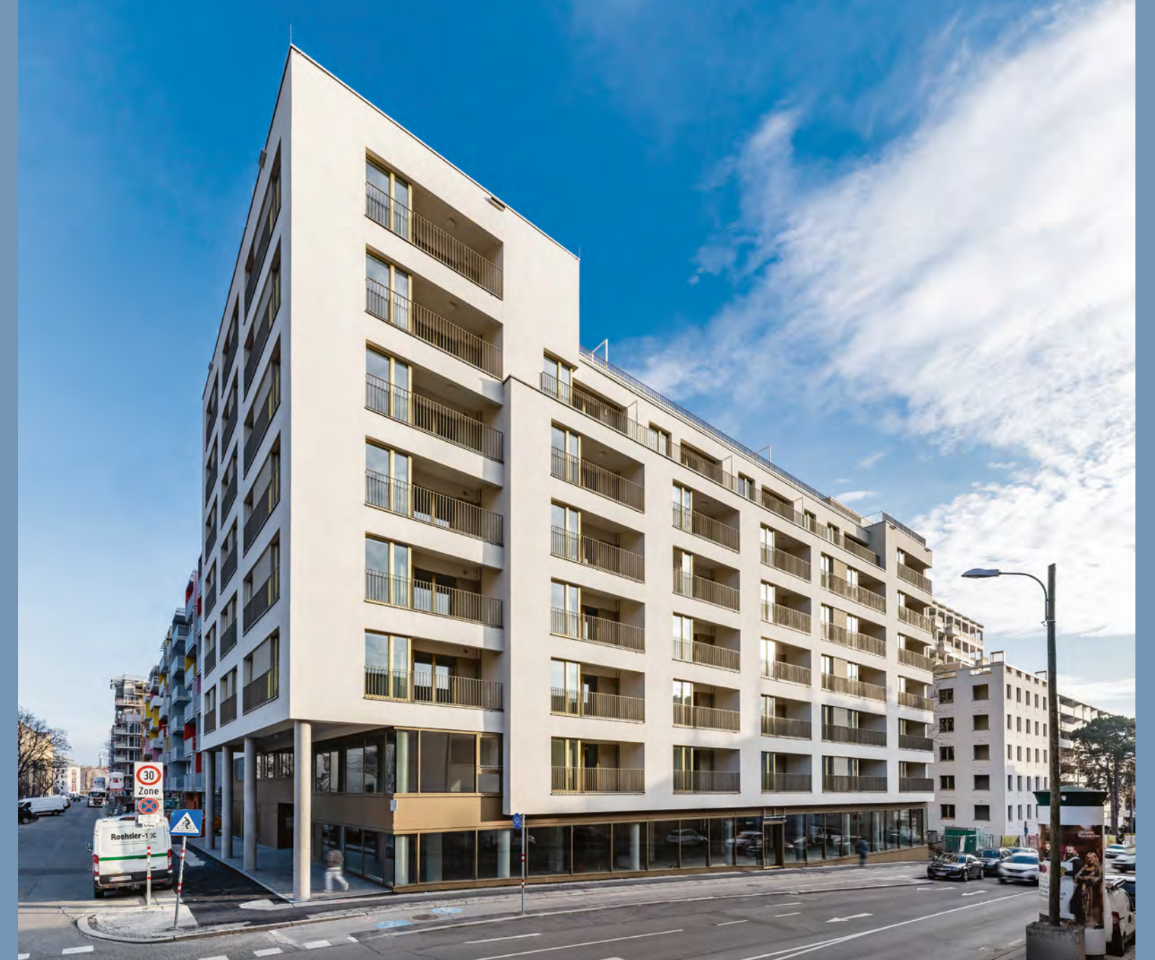
Froetscher Lichtenwagner Wohnbau Spallartgasse, Wien, 2021
