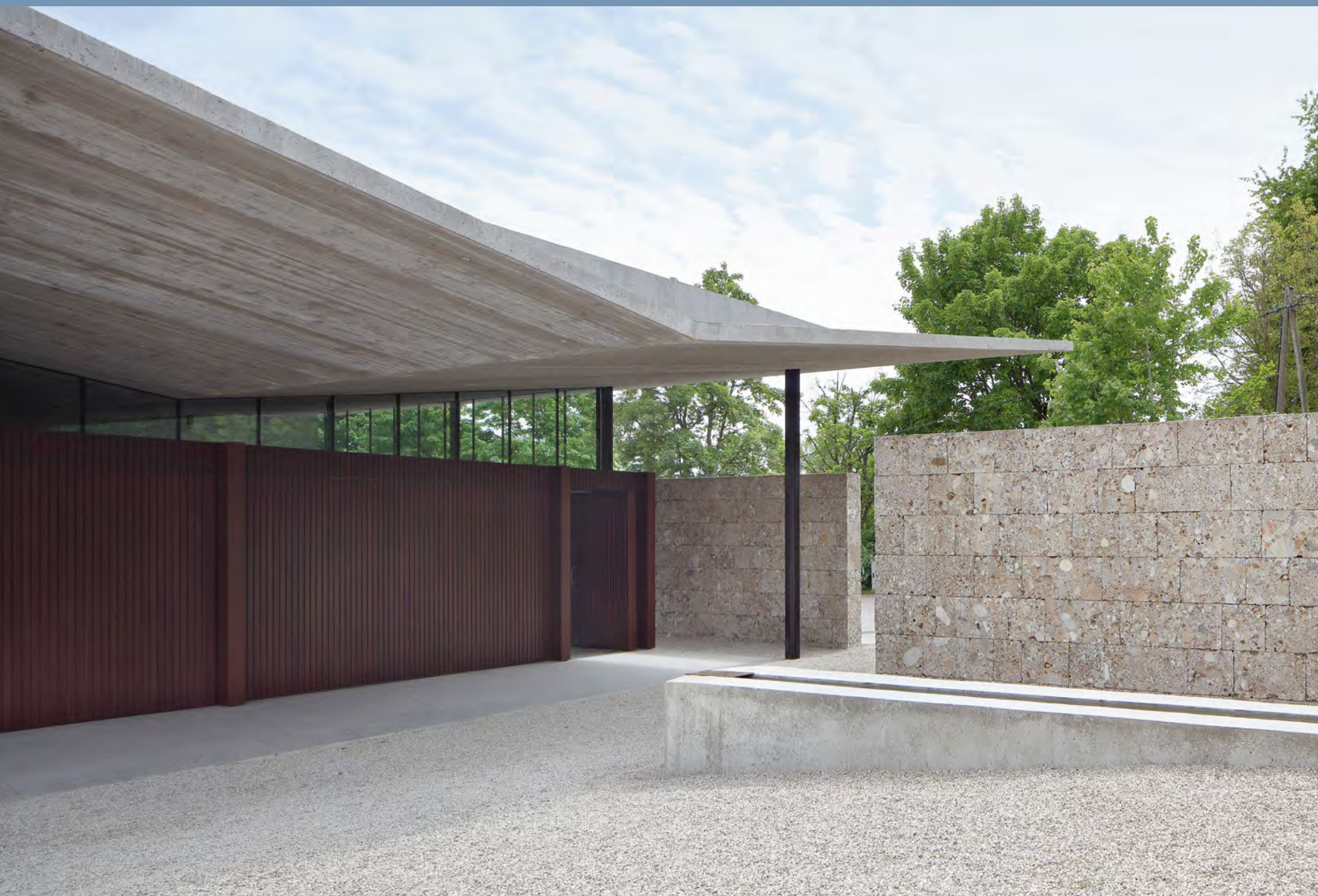
Moser und Hager Aufbahnhalle, Krematen an der Krems, Oberösterreich, 2021 Foto: Gregor Graf
