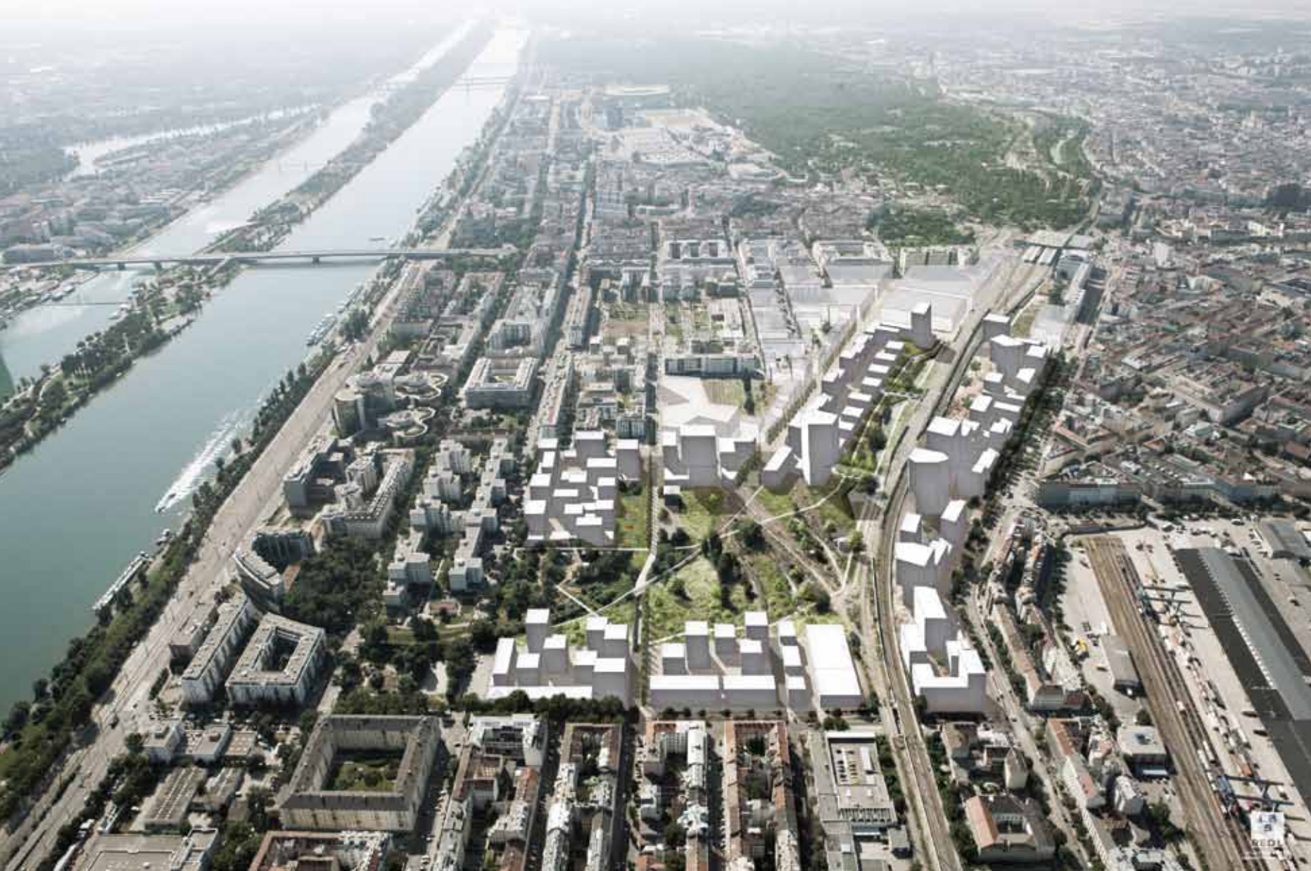
StudioIlay | Agence Ter | Traffix „Freie Mitte“ Nordbahnhof, Wien, Leitbild 2015 Vogelperspektive: Agence Ter | ÖBB Luftbildservice Redl
