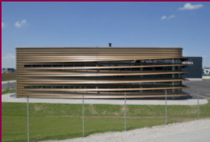
kienesberger schröckenfuchs Firma Eurowheel, Vorchdorf, 2013 Turn On Partner: Kalzip GmbH Foto: Andrew Phelps
